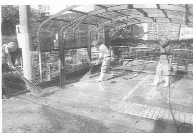
上・国道19号(富士見町)の応急復旧/下・民家に流れ込んだ土砂の清掃 【東濃を襲った9月の豪雨災害では、業界あげて幅広い対応にあたった】
